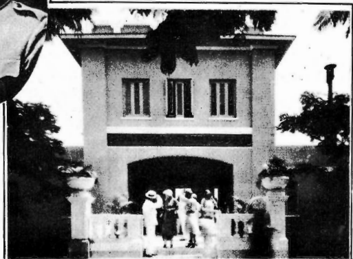
Un aspecto del nuevo edificio construido por la Secretaría de Sanidad con destino al Patronato Anti-tuberculoso, y que fué inaugurado el último domingo.
